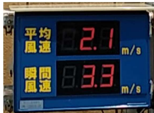
【現場 デジタル表示機】
