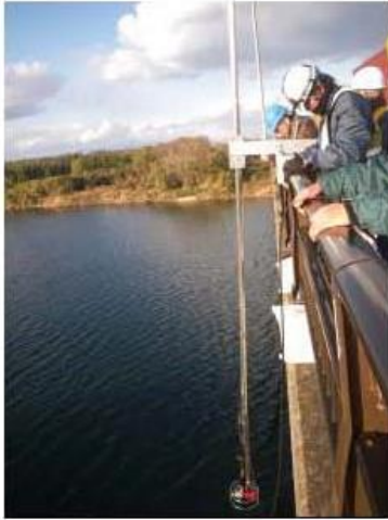
洗掘 計測状況①
